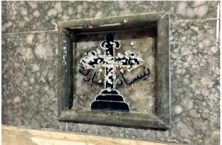
Verwüstungen an einer Kirche im Irak.
