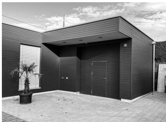
Der neue Lageranbau beim Jugendzentrum von aussen.
